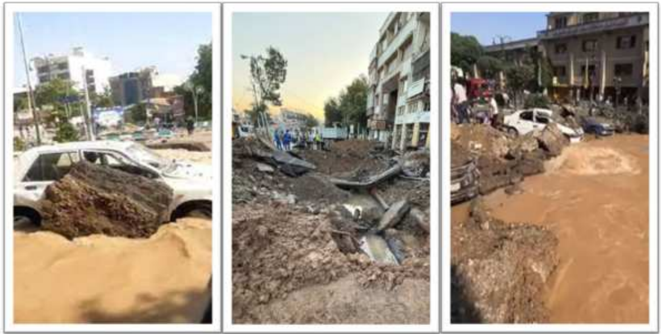
Le ciblage de la principale conduite d'eau a provoqué une inondation dans le quartier de Tajrish
